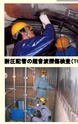
ボイラチューブ保護皮膜(清射)の健全性評価 ボイラにおける定期検査 IICレビュー-38,40号より
